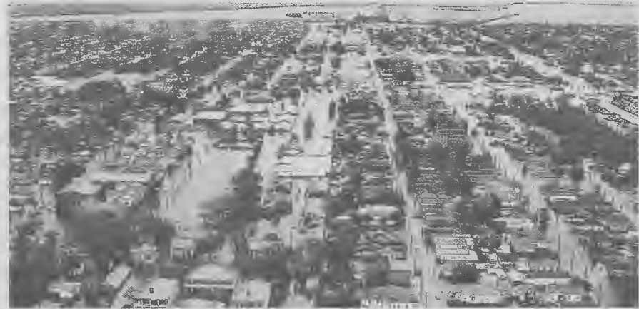
Das Foto der US-Küstenwache zeigt: Die Umgebung von New Orleans steht nach dem Hurrikan Katrina vollständig unter Wasser.
