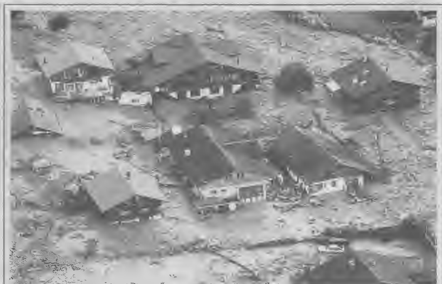
In Brienz wurden acht Häuser vollständig und dreizehn weitere teilweise zerstört.
