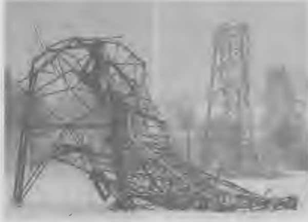
Die geballte Kraft des Eises liess selbst stabilen Strommasten keine Chance. Bild: key
